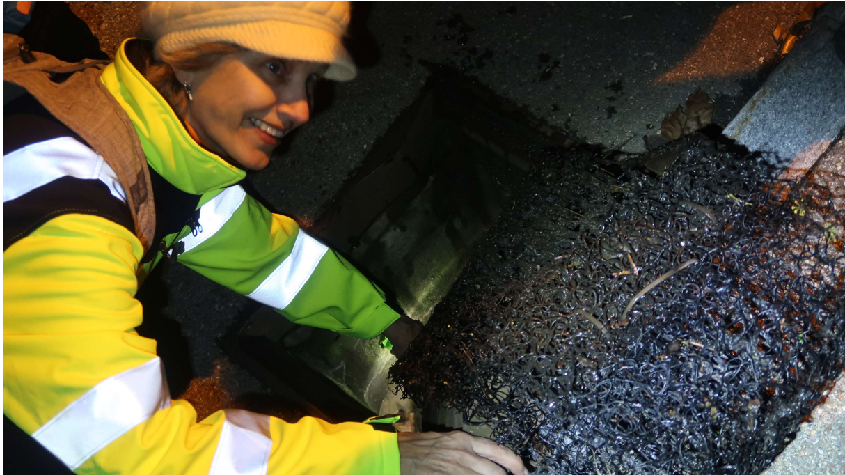
Abb. 3. Christina Feierabend zeigt uns das schwarze Geflecht (rechts im Bild), das für die Amphibien als Leiter dient, um aus den Schächten zu kommen.
